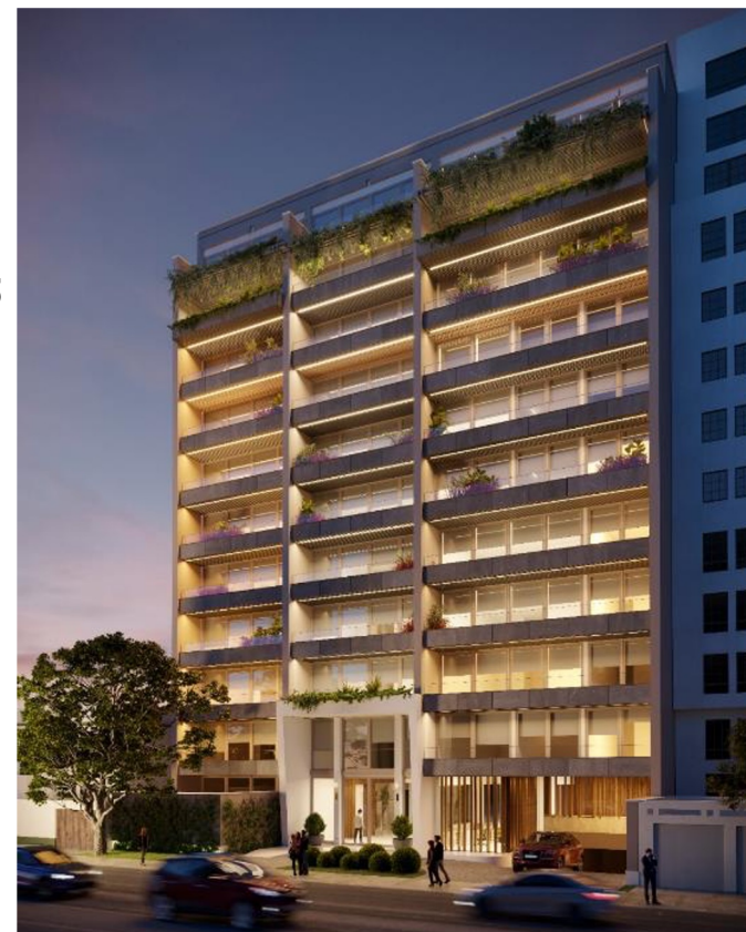
VI VE Edificio BASADRE 1235 San Isidro
